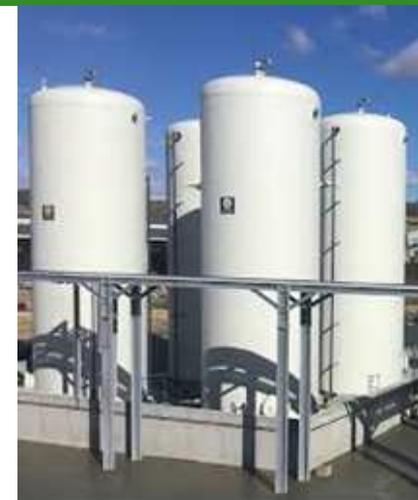
**SOLUCIÓN: Ensayo por emisión Acústica bajo UNE-EN 15.865 (Corrosión activa en fondos) + Informe de Solución Técnica Alternativa por OC**
